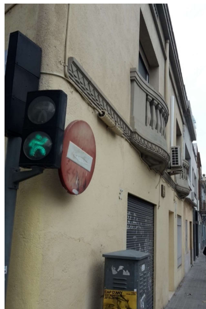
façana C/ Sant Bru
