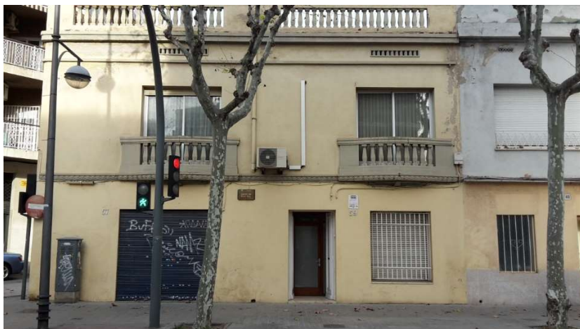
façana C/ Sant Bru
